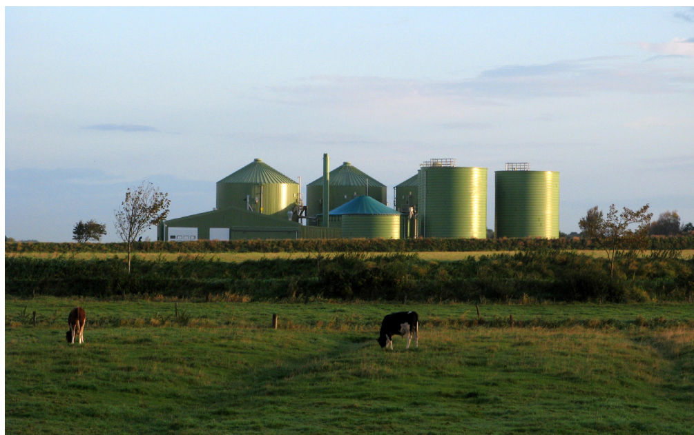
Installation de méthanisation à la ferme à Lohe-Rickelshof, Land du Holstein, Allemagne, photo par Dirk Ingo Franke, 2009 (CC)
