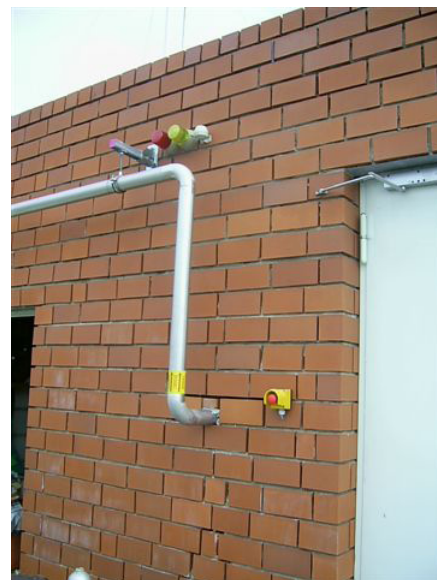
Dispositif « coup de poing ». Source : Bio-Nrj.
